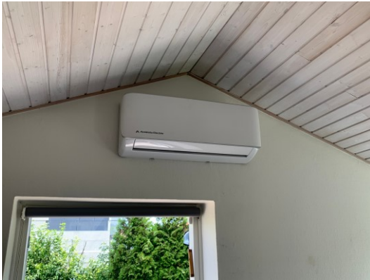
Luft til luft varmepumpe Som supplement eller midlertidig erstatning
