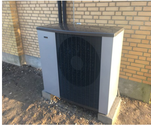
Luft til vand varmepumpe Erstatter gas/fjernvarme
